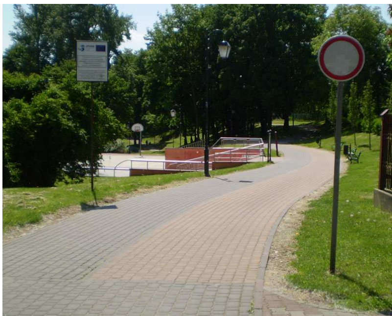
Fot. 5. Odnoga od strony ul. Słowackiego - inny kolor nawierzchni ale brak oznakowania, zakaz ruchu bez wyłączenia rowerów
