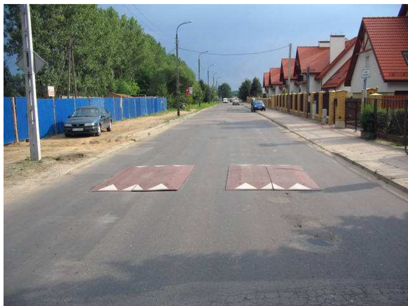
Fotografia 18. Wyspowe progi zwalniające, z przerwami zapewniającymi możliwość wygodnego przejazdu zarówno autobusom jak i rowerom (Białystok, ul. Brzechwy)
