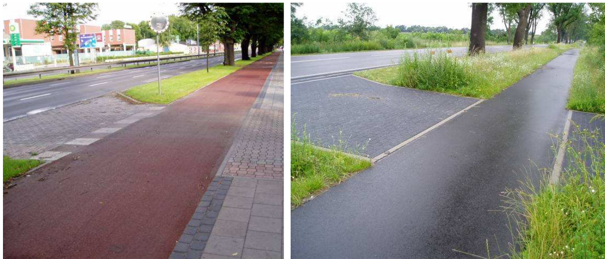
Fotografia 6. Zachowanie ciągłości nawierzchni drogi dla rowerów (Gdańsk)
