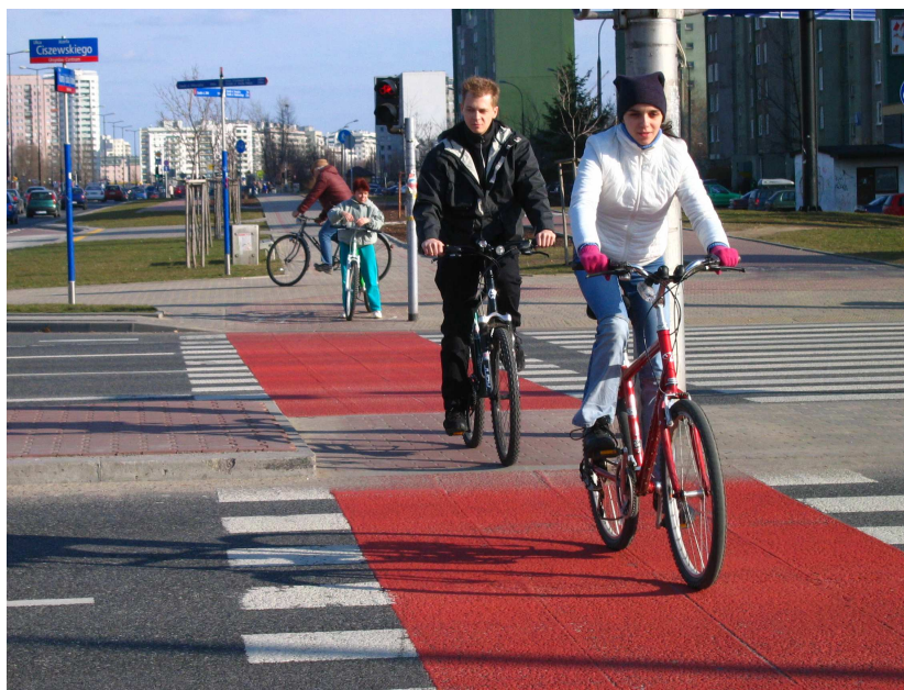
Fotografia 35. Przykład kolorowej nawierzchni przejazdów dla rowerzystów
