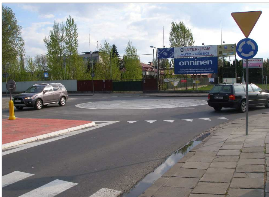
Fotografia 42. Przykład przebudowy skrzyżowania na minirondo za pomocą elementów prefabrykowanych bez konieczności przebudowy nawierzchni i krawężników (Warszawa, ul. Kowalczyka / Klembowskiej)
