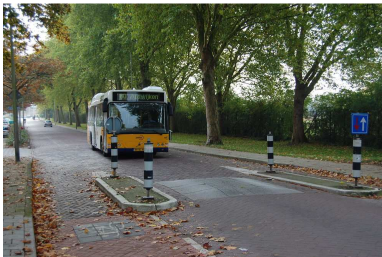
Fotografia 20. Płytowy próg zwalniający – przyjazny dla autobusów – wewnątrz szykany. Rowerzyści omijają szukanę bokiem
