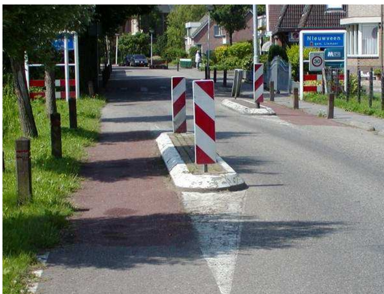
Fotografia 21. Szykany też zmuszają kierowcę do zwolnienia, choć nie powodują tak nieprzyjemnych wstrząsów dla jadących samochodem, jak progi spowalniające
