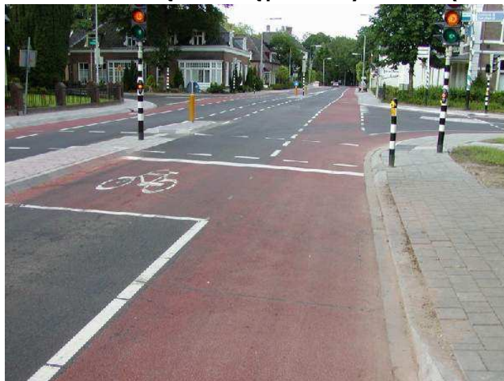
Fotografia 11. Pas dla rowerów ze służą rowerową przed skrzyżowaniem (De Steeg, Holandia)
