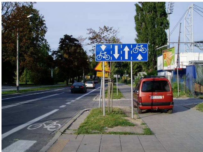
Fotografia 7. Pasy ruchu dla rowerów na ul. Międzyparkowej w Warszawie
