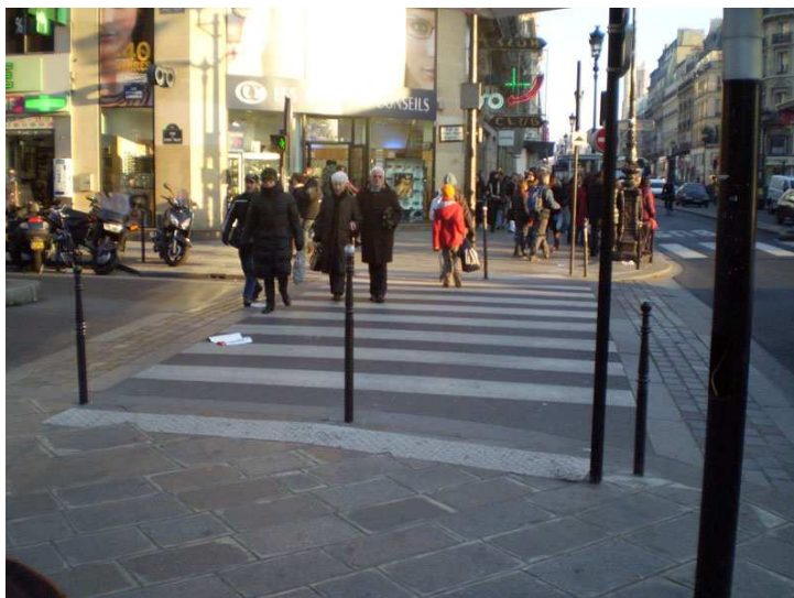
Fotografia 22. Wyniesione przejścia dla pieszych (wraz z ewent. przejazdami dla rowerzystów przy wjeździe z ulicy zbiorczej na ulicę ruchu uspokojonego z jednoczesnym zwężeniem przekroju jezdni i małymi łukami w formie tzw. „bramy” (Paryż)
